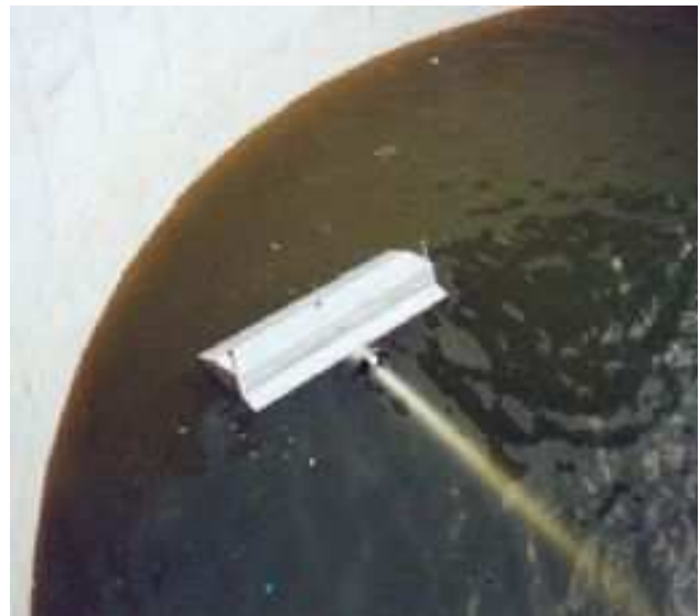
Decantador en fase de extracción de agua clara
